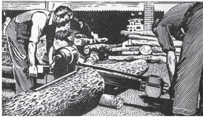
Serra motoritzada. Llibret Un siglo al servicio de la industria textil . 1953. Torneria Pujol.
