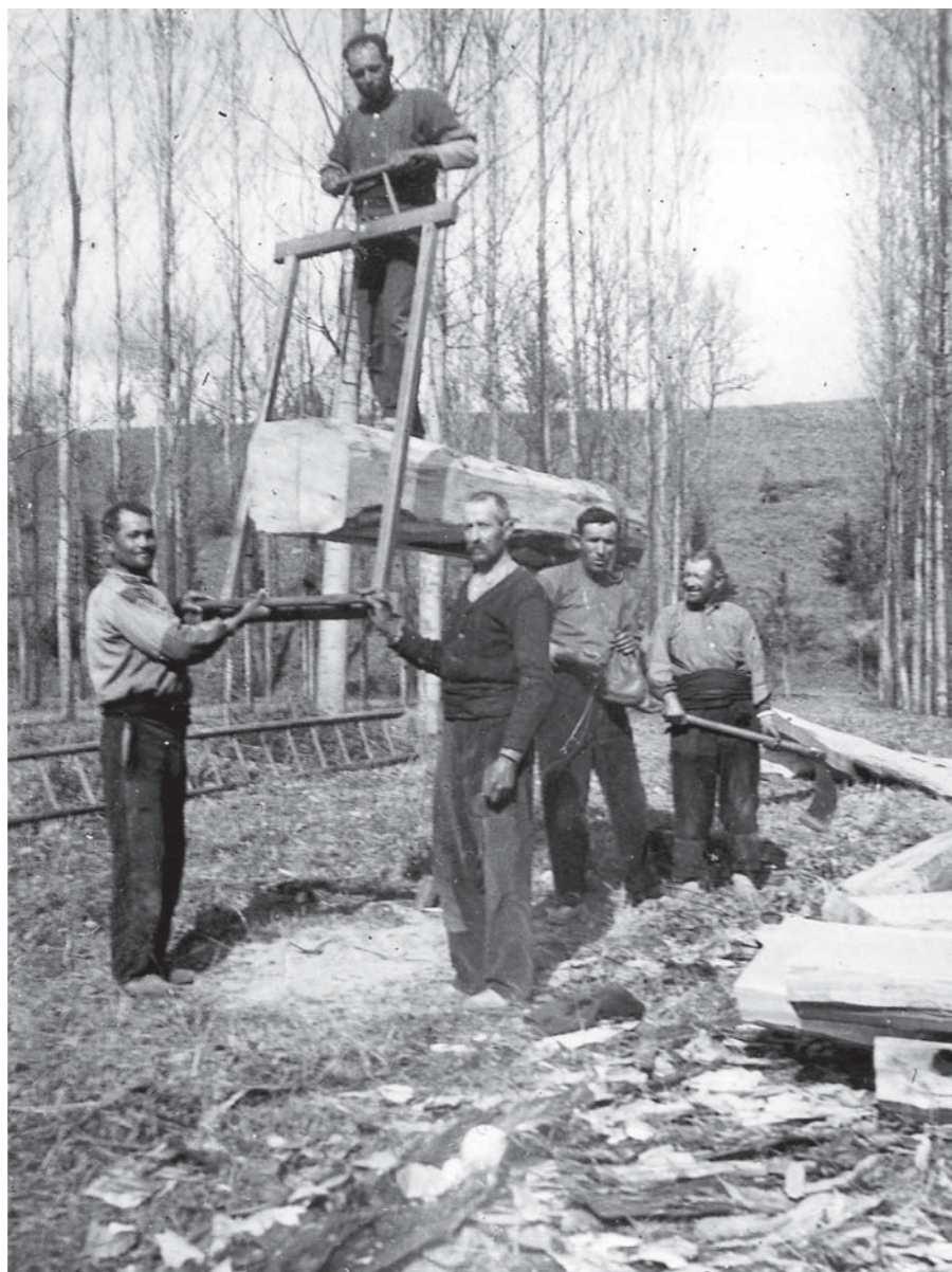
Treballant a la pollancreta de la Coromina. Amb la pollina i la serra de bastidor es feien bigues i taulons per a la construcció. Arxiu Municipal de Torelló, Fons L'Abans Torelló.
