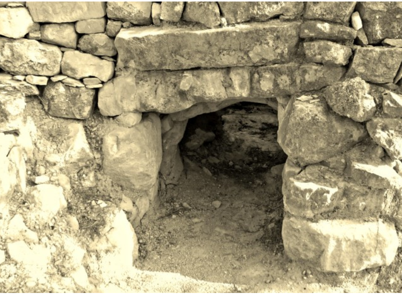
Boca de càrrega i buidatge de les soques de ginebre (Bovera).
